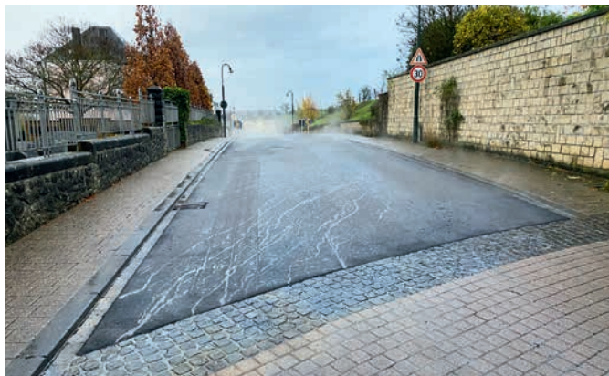
12. Beleuchtung der Fußgängerübergänge: die Leuchtmasten an der „route de Luxembourg“ und der „Rue d’ Olingen“ in Roodt/ Syr wurden aufgestellt.
