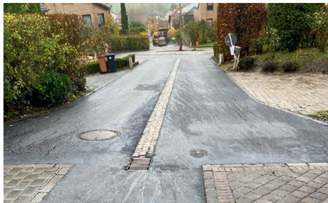
12. Eclairage du passage pour piétons. Les poteaux d'éclairage de la « route de Luxembourg » et de la « rue d'Olingen » à Roodt/Syre ont été mis en place.
