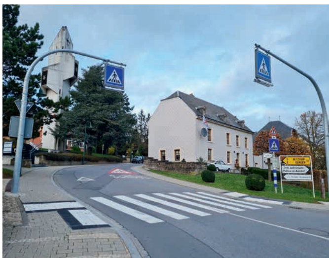
13. Umrüstung der Straßenbeleuchtung auf LED in Berg, Betzdorf und Olingen. Der Auftrag für die Arbeiten liegt vor und die Arbeiten werden voraussichtlich Ende des Jahres beginnen.
