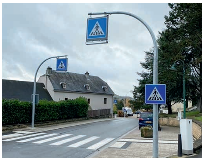
13. Passage au LED de l'éclairage public à Berg, Betzdorf et Olingen. La commande des travaux a été envoyée et les travaux devraient commencer à la fin de l'année.
